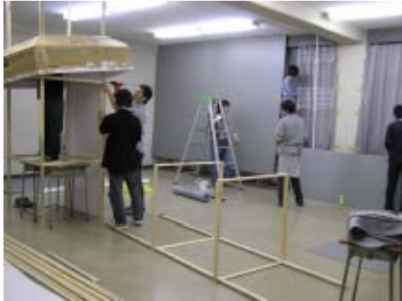
【前日の作業風景】
