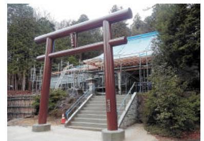
再建工事が進む山津見神社の拝殿＝福島県飯館村佐須
